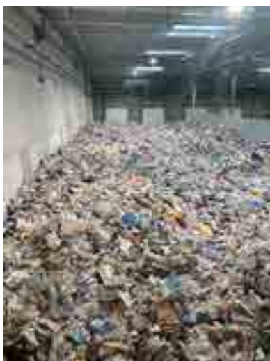
Gigantesque alvéole de stockage des déchets avant tri
